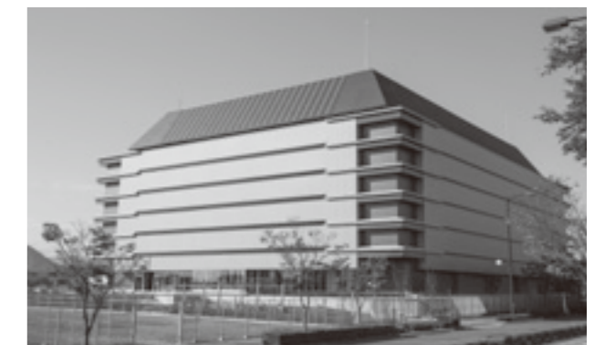
●新高松データセンター「Powerico (パワリコ)」の外観
